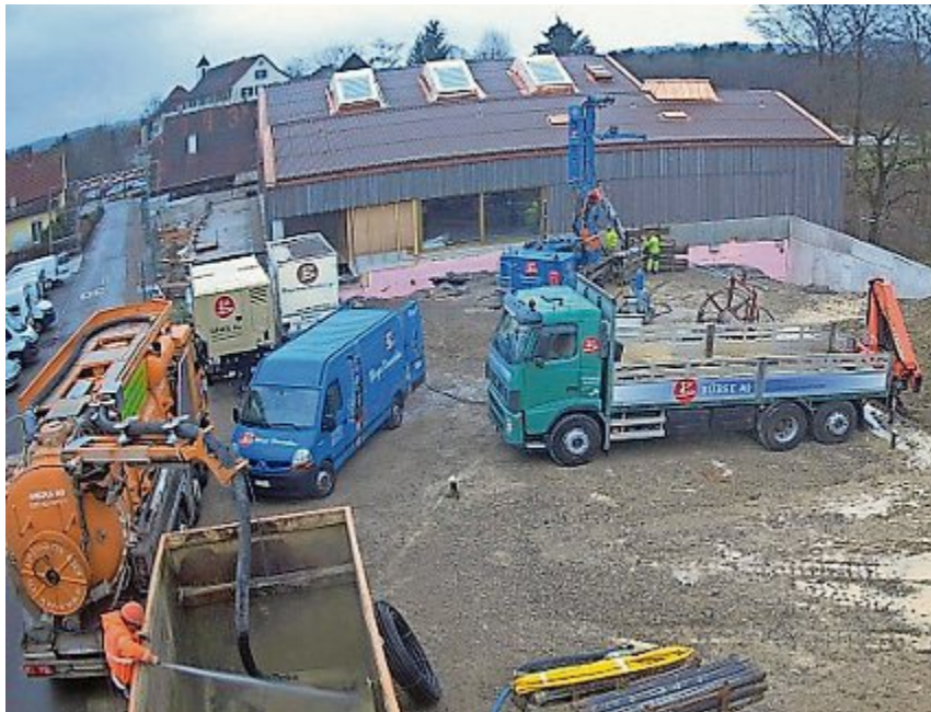
Endspurt in Pfyn: Die neue Mehrzweckhalle wurde bereits vom Gerüst befreit. z.V.g.
